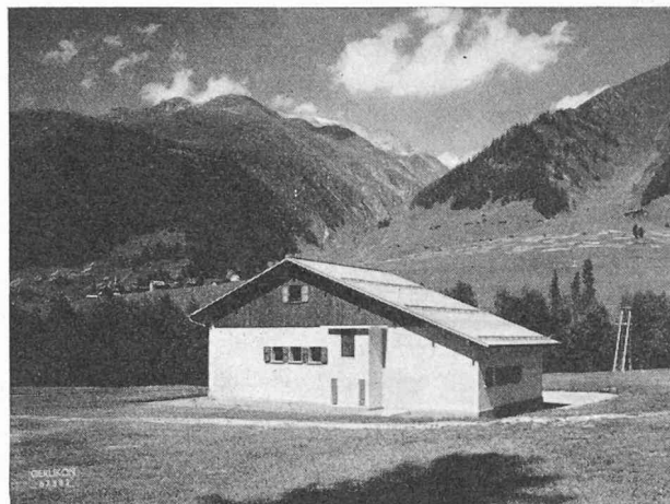
Fig. 16. — Centrale, vue d'amont.
