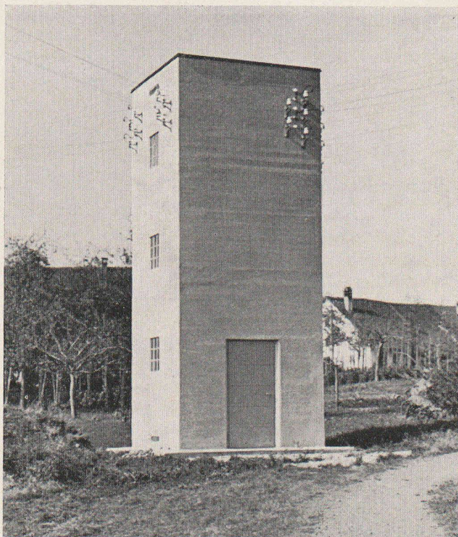
Exemple d'une station de transformateur purement utilitaire. Date de construction : env. 1930 *
