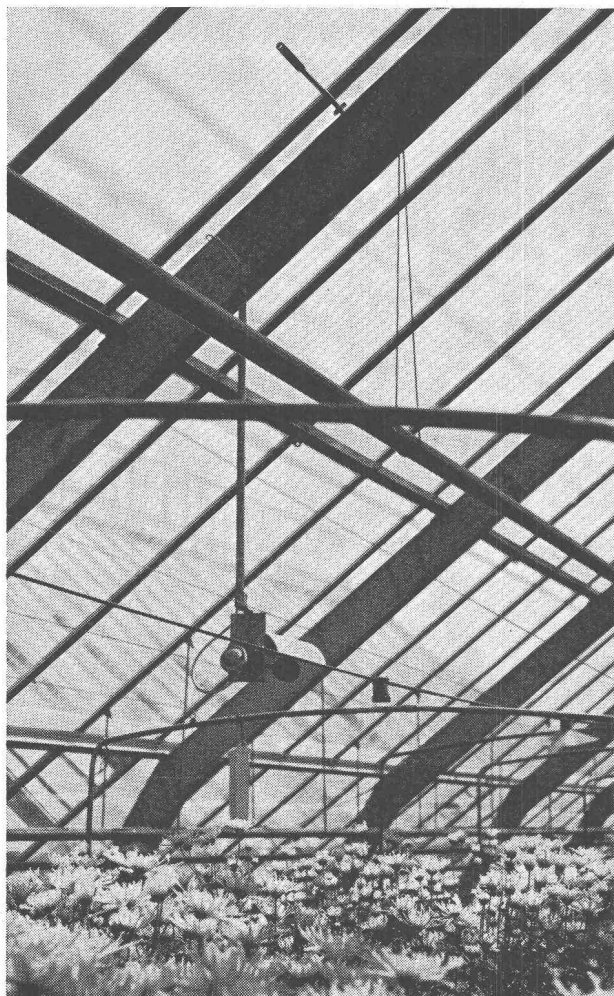
Serre avec contrôle de la température en fonction de la lumière du jour.
