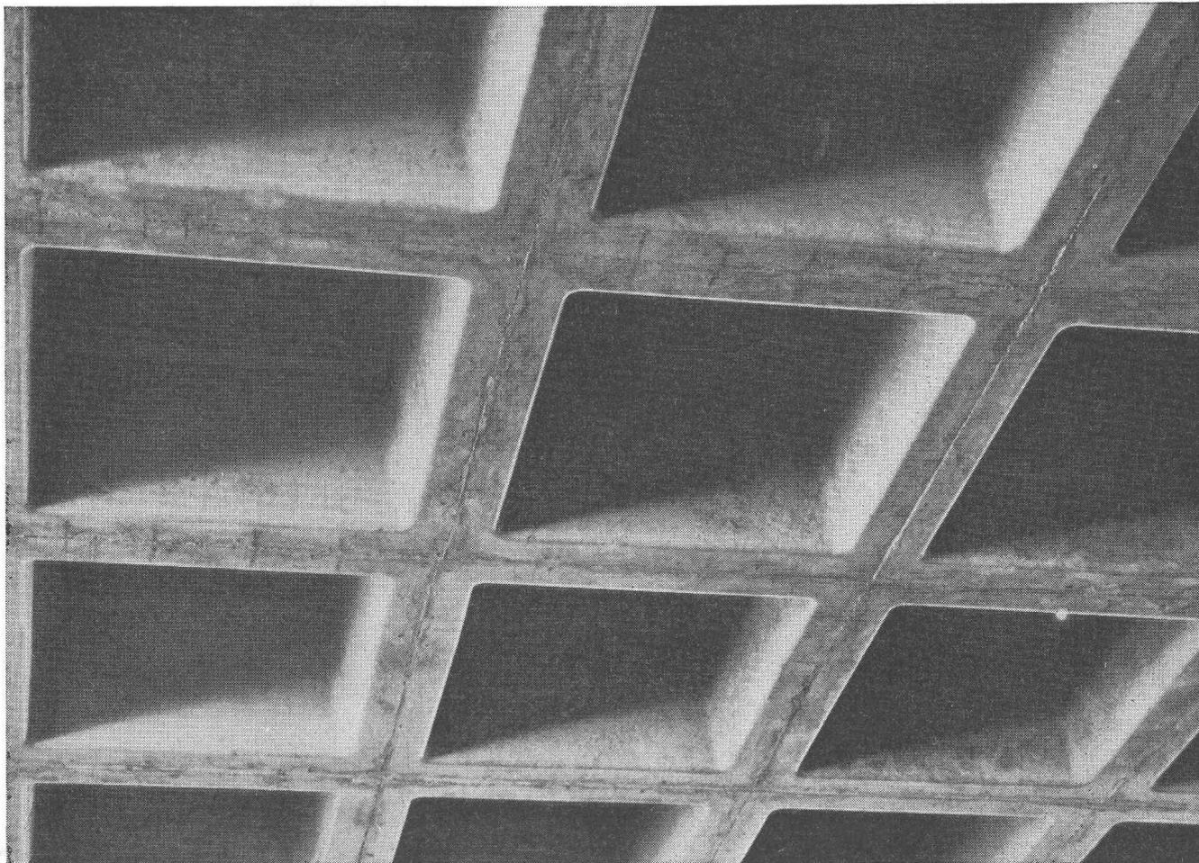
Dalle alvéolée réalisée au moyen d'un jeu de caissons de coffrage en résine stratifiée armée
