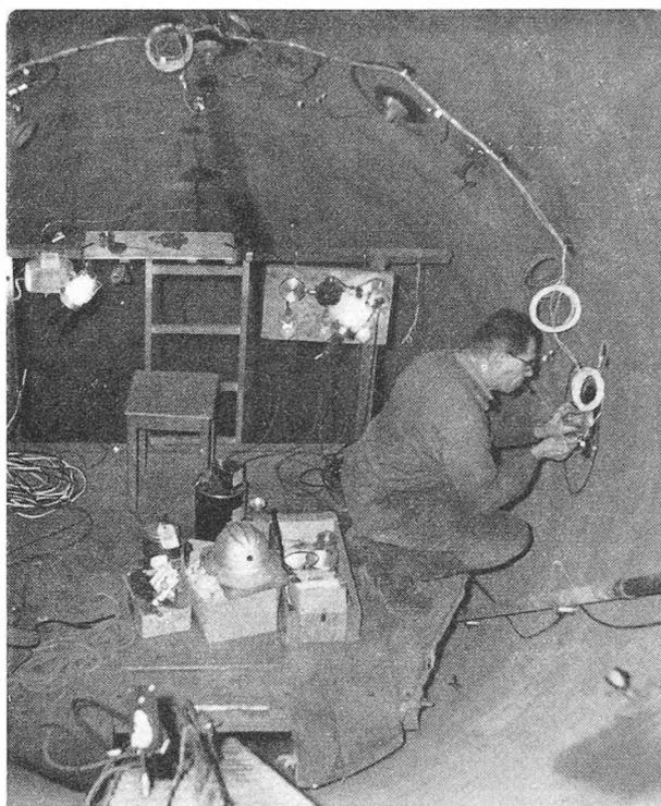
Fig. 5. — Mise en place des jauges de contrainte.
