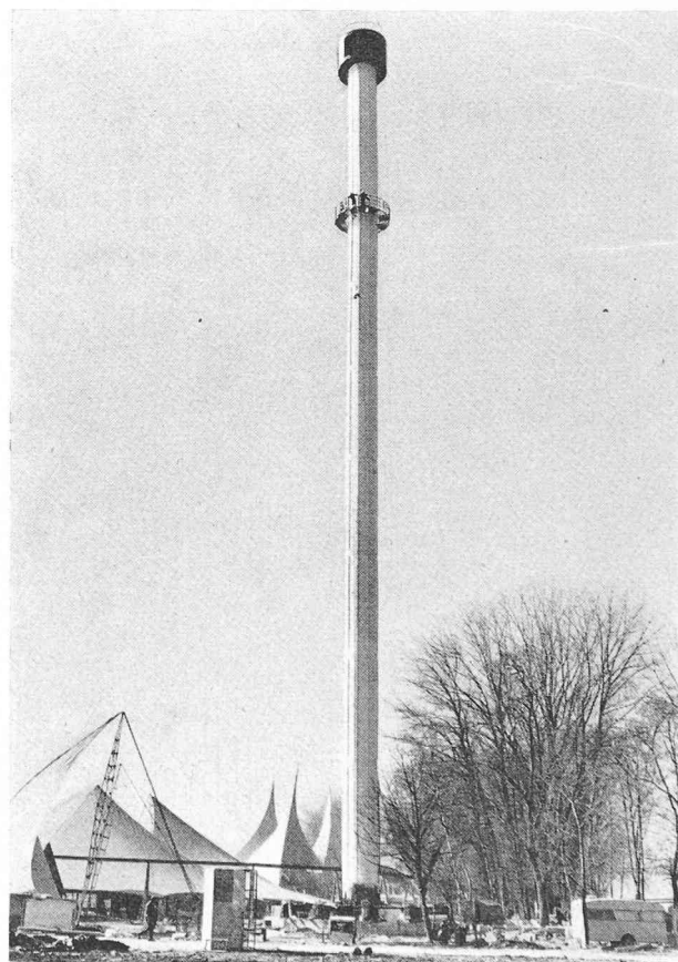
Fig. 1. — Le gros œuvre de la tour en achèvement.
