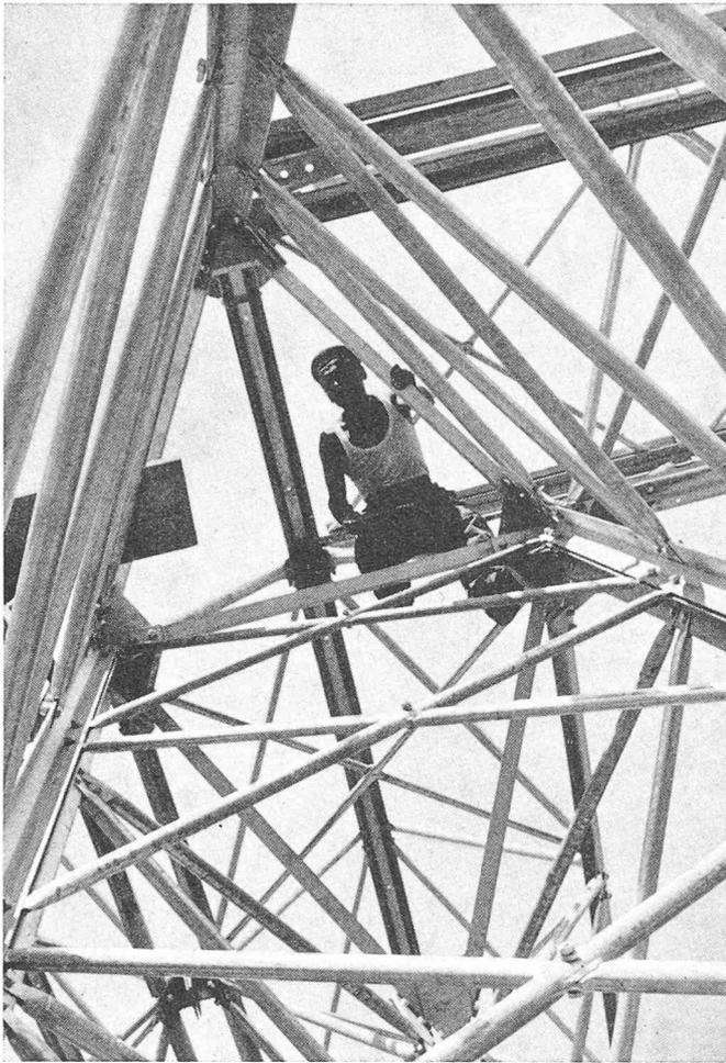
Fig. 34. — Vue intérieure d'un angle d'un cadre montrant les particularités d'attache des diagonales et du contreventement aux membrures.
