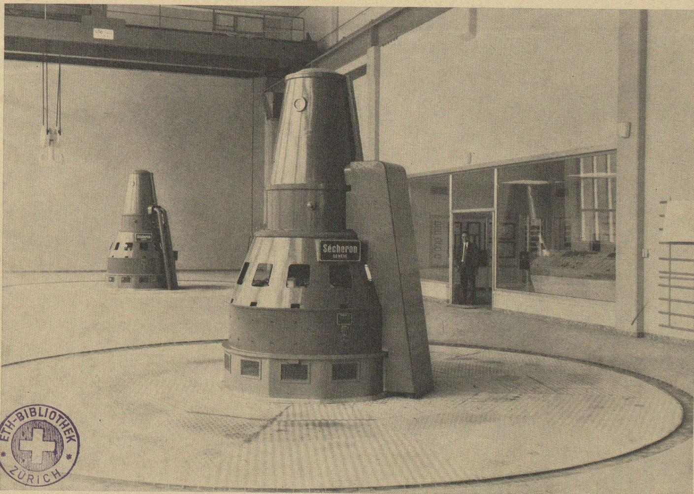
2 alternateurs synchrones triphasés à axe vertical 42 MVA, 214 t/min, 10 kV avec leur équipement complet d'excitation et de réglage livrés à la centrale de SCHIFFENEN-EEF, par Sécheron Genève.
