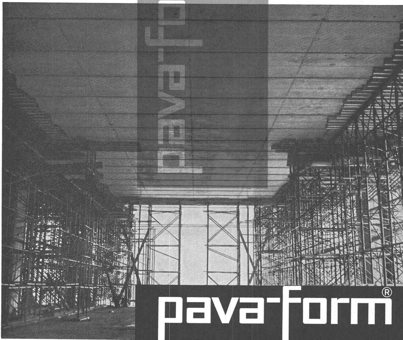
Le plafond de cet entrepôt est constitué d'éléments préfabriqués, obtenus en utilisant les panneaux Pava-form.
