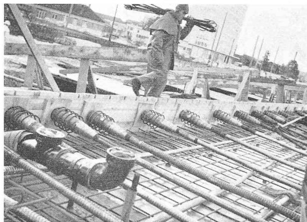
Fig. 2. — Têtes des câbles de l'entrepôt avant la pose de l'armature morte supérieure et le frettage des têtes.
