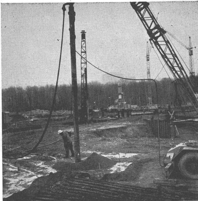
Compactage en profondeur selon le procédé **RDV** pour réduire la perméabilité de plusieurs bassins de décan-tation.
