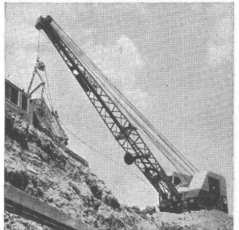
«Lors des travaux de terrassement d'un passage inférieur de l'autoroute au Mont s/Lausanne une 30-RB et deux dumpers étaient en service. Nous avons déblayé 1500 m<sup>3</sup> en 9 h 1/2», déclare Toni Nussbaum, conducteur d'une 30-RB.
