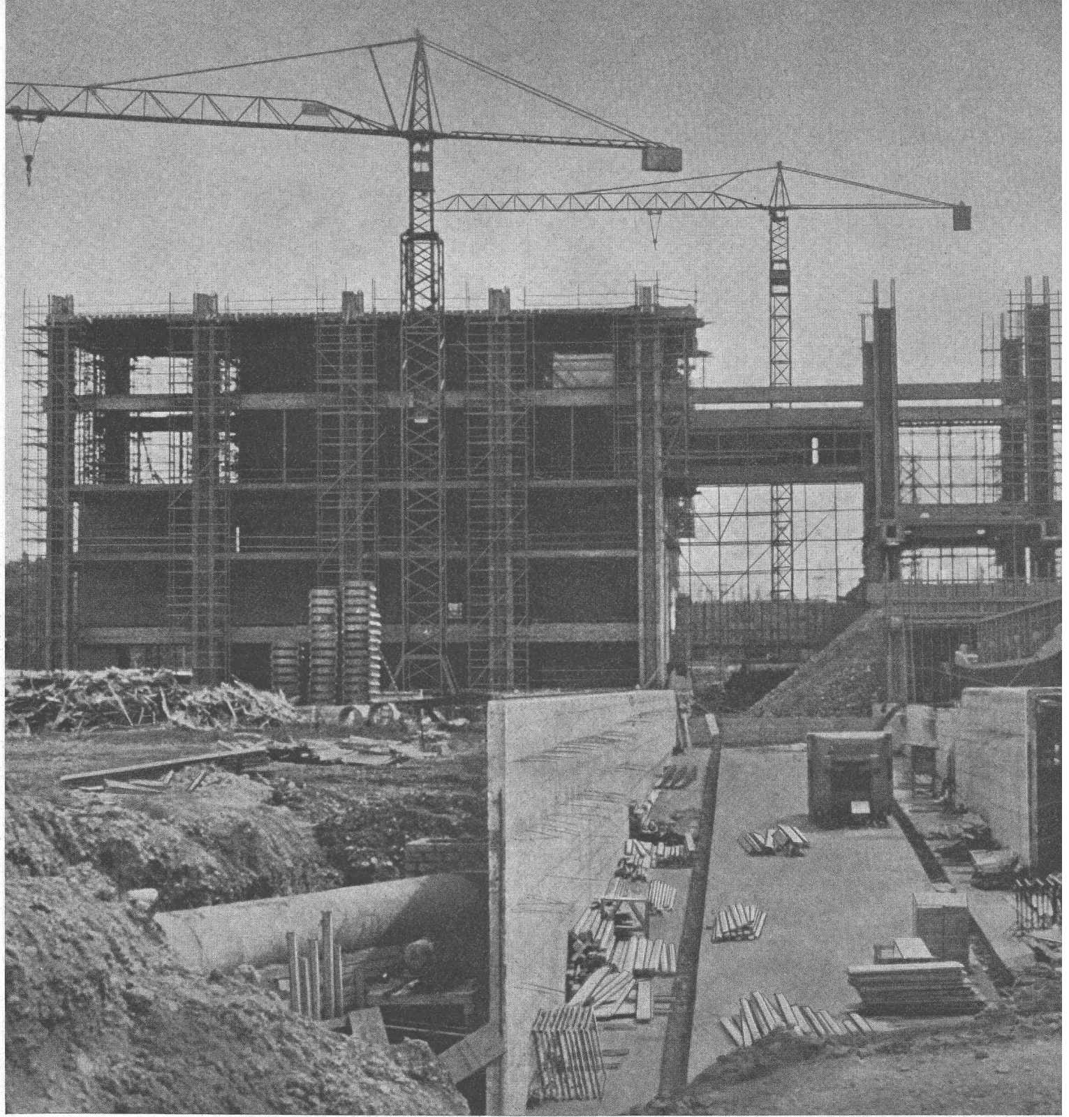
Usine d'incinération des ordures ménagères de Genève aux Cheneviers (en construction. Photo janvier 1965.)
