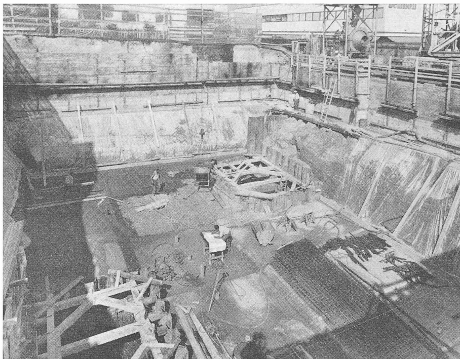
Fig. 29. — Enceinte de fouille, Schwamendingen. Ancrages TUBFIX en alluvions.
