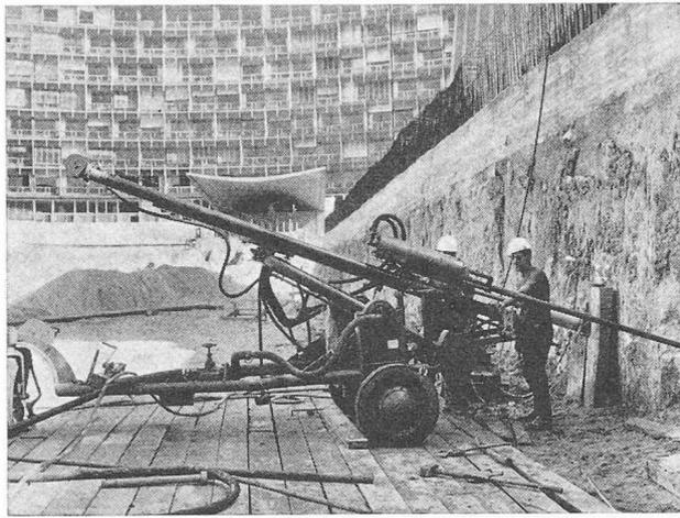
Fig. 4. — Mise en œuvre des ancrages arrière.
