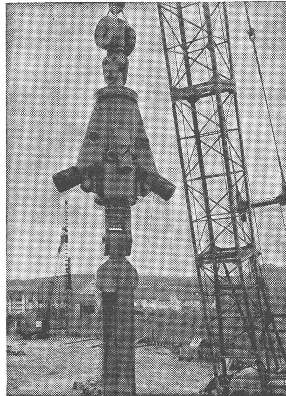
Extracteur lourd Delmag P 14 pour palplanches Jusqu'à 15 m.
