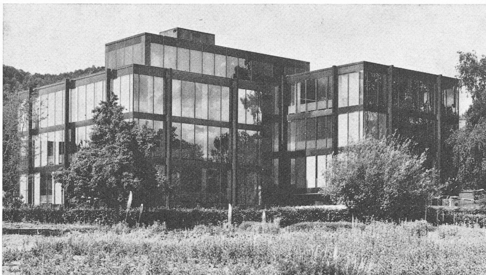
Fig. 1. — Façade du bâtiment de Ventilation S.A. , à Stäfa, équipé de verres « Stop-Ray ».
