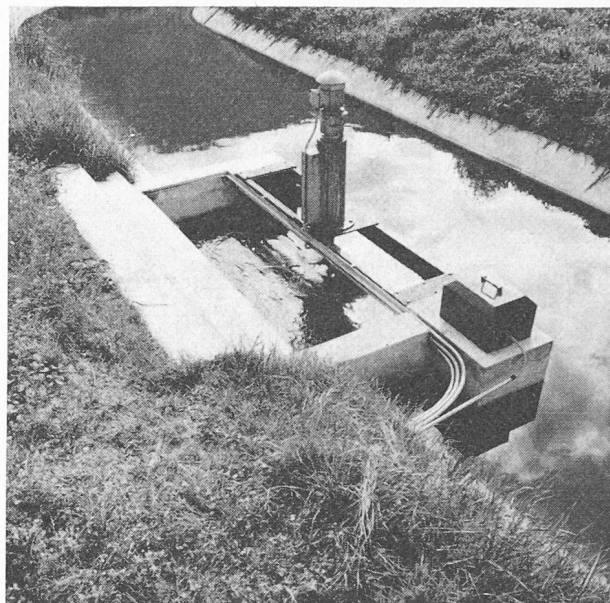
Fig. 5. — Le déversoir et la boîte à électrodes.
