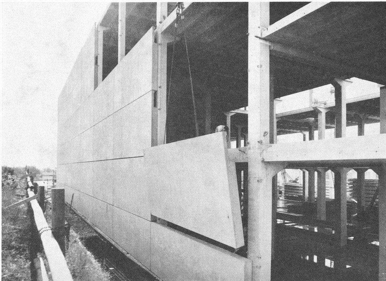
Fig. 8. — Montage des éléments de façade.
