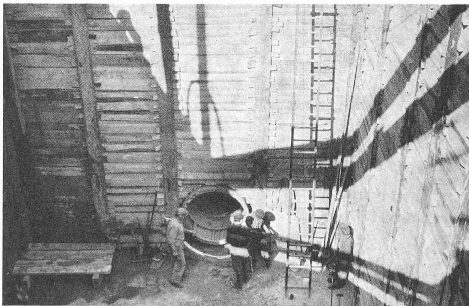
Fig. 7. — Essais sur modèle « in situ » : un cylindre de 1,5 m de diamètre, simulant le bouclier, a été enfoncé dans le sol encaissant, au fond du puits de départ du tunnel.
