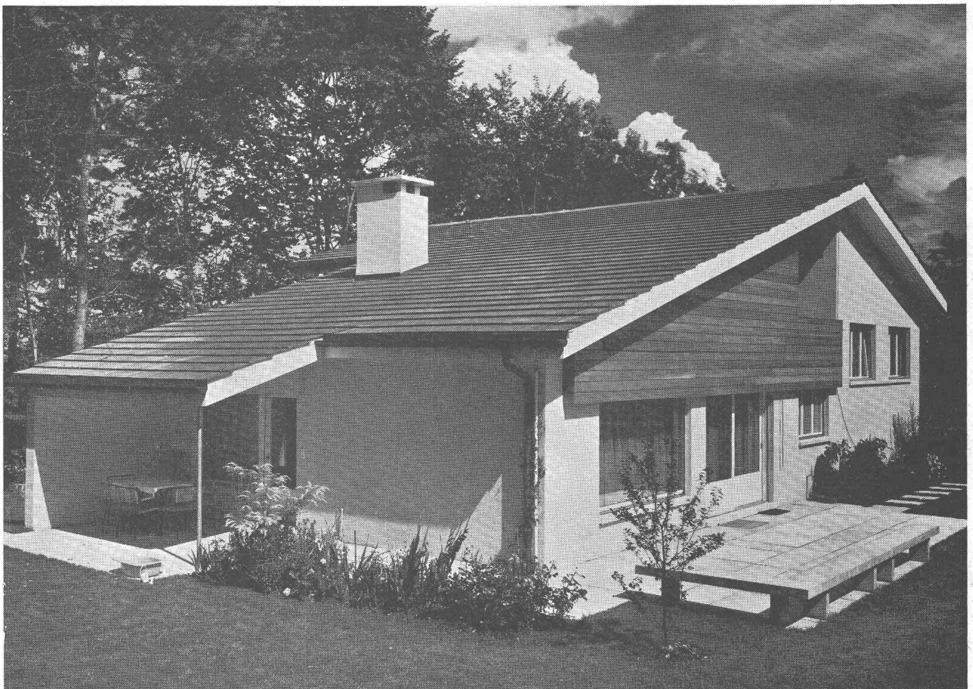
Toiture recouverte de tuiles en béton REDLAND
