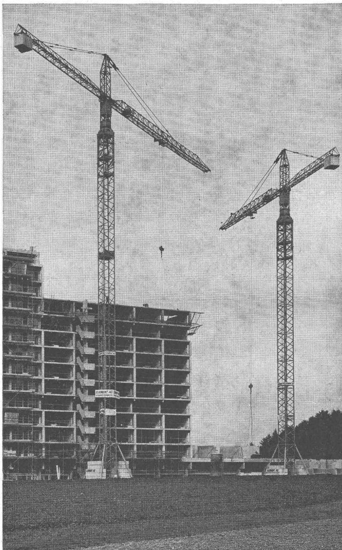
Montage hydraulique, sans aide auxiliaire. La commande à distance permet de diriger la grue d'un endroit quelconque.
