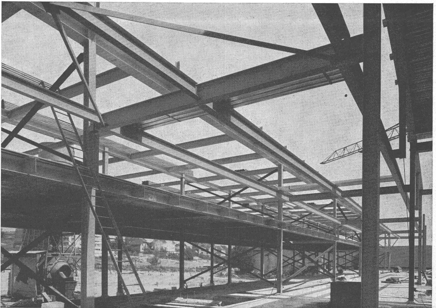
Charpente métallique de l'usine DEMAUREX à Renens, exécutée par la maison ZWAHLEN & MAYR SA, Aigle-Lausanne. Architecte : F. Brugger, FAS-SIA, Lausanne.
