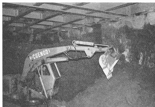
Fig. 16. — Pelle hydraulique sous la charpente.
