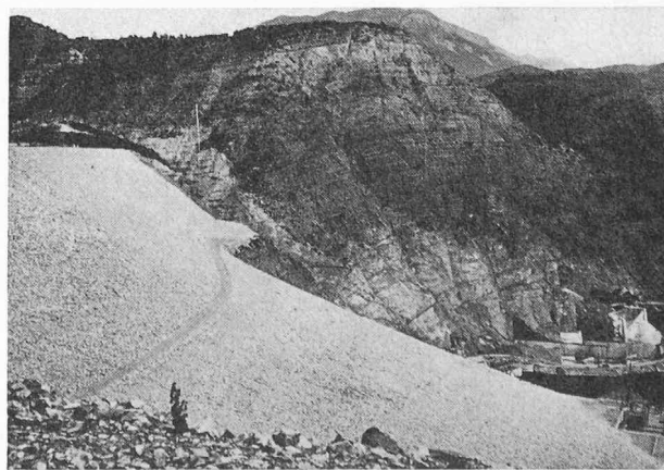
Fig. 44. — Digue de Serre-Ponçon. Vue du parement aval.
