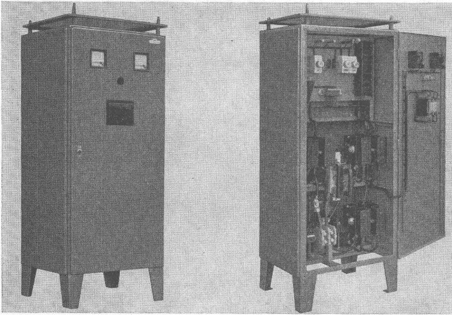
Les redresseurs Stabilomat GUTOR, équipés de thyristors, sont utilisés aussi bien pour l'alimentation directe des réseaux à courant continu sans batteries que pour des circuits de secours avec accumulateurs chargés en tampon. La tension et le courant sont à réglage progressif, sans faire appel à des contacts. La tension réglée est maintenue stable dans une tolérance de  $\pm 0,5\%$ . L'ondulation résiduelle de la tension de sortie est très faible.
