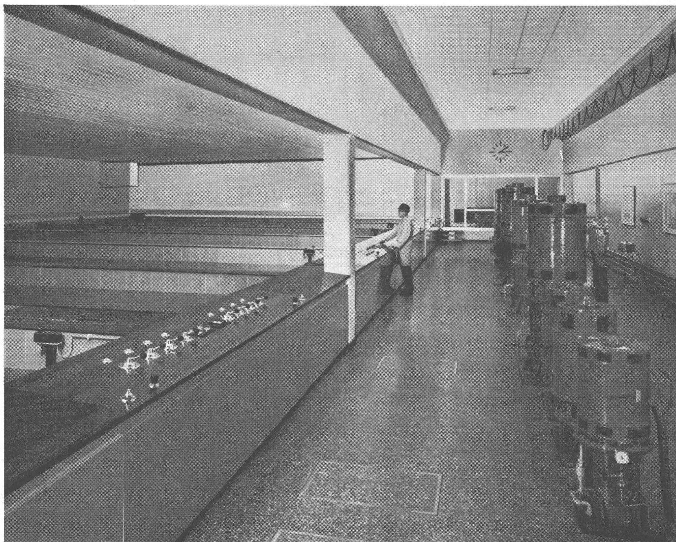
Station de filtres rapides «Champ-Bougin» de la ville de Neuchâtel ayant un débit de 1800 m 3 /h. A droite, les moteurs d'entraînement des pompes
