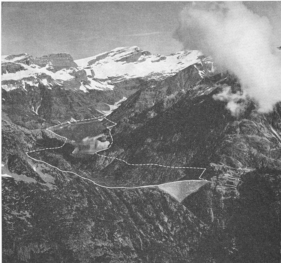
Fig. 3. — Photo-montage de la retenue et du barrage d'Emosson. A l'arrière-plan, le lac existant de Barberine.
