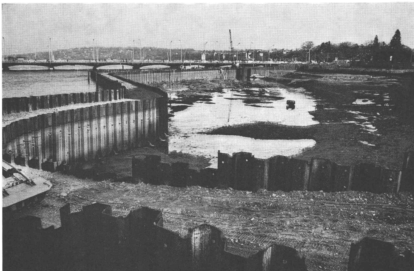
Batardeau pour l'excavation du Parking du Pont du Mont-Blanc, Genève
