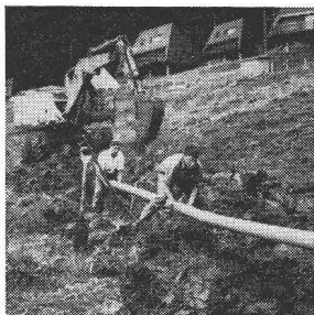
Canalisation Schwyz: Rothenturm
