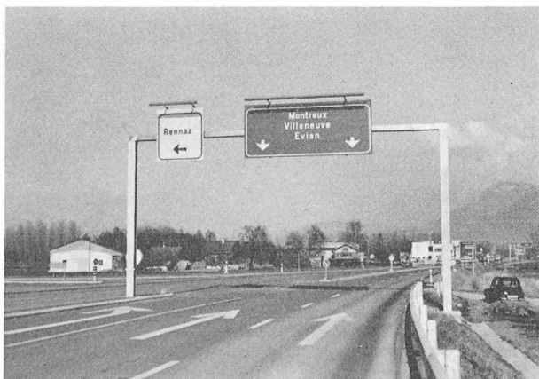
Fig. 3. — Portique de signalisation à Rennaz.
