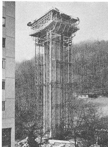
Fig. 7. — Palée 3 prête à recevoir les chariots.
