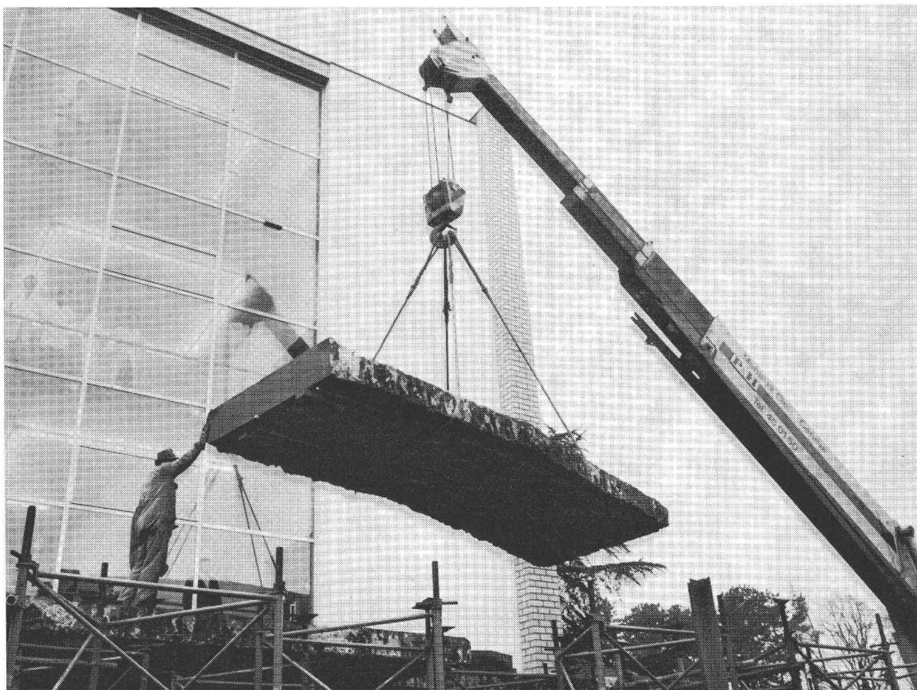
Institut Battelle Carouge GE Dalle de 10 t découpée à la lance d'oxygène, sans bruit, sans vibrations, sans poussière
