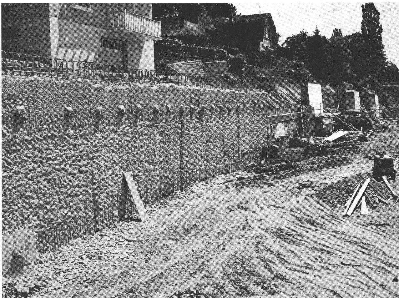
Mur de soutènement Floraire, route Blanche, Genève Maître de l'ouvrage: Département des travaux publics, Genève Projet: P.-R. Klemm, ingénieur civil, EPFL, SIA, Genève Exécution en association 1971
