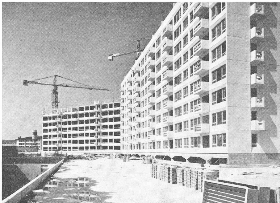
Fig. 7. — Le bâtiment en cours de montage.
