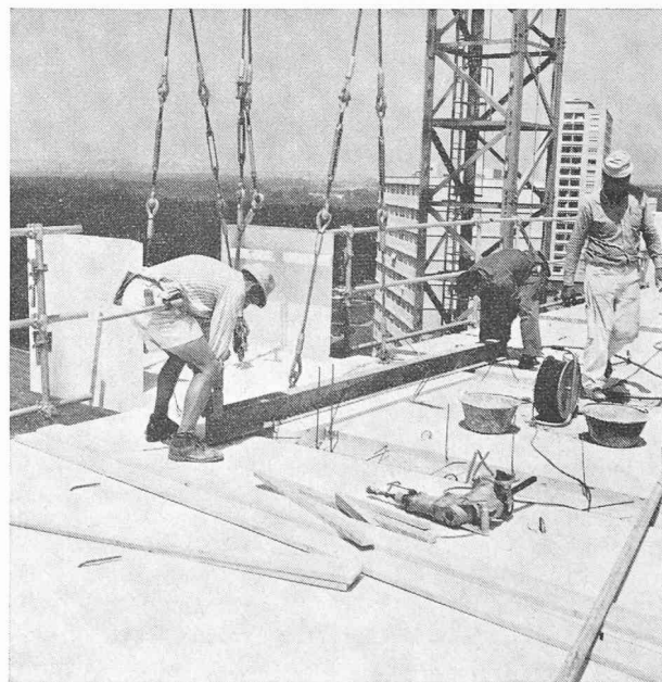
Fig. 8. — Pose d'un balcon.
