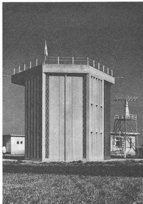
Fig. 2. — Station d'aérodynamique à Payerne. Plaques à nervures. (Architecte : Constructions fédérales, Berne.) (Ingénieurs : J.-P. Carroz et W. Küng, ing. SIA, Payerne.)
