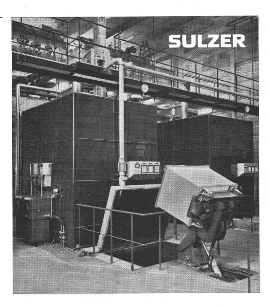
Centrale de chauffe d'un entrepôt équipée de deux chaudières tubulaires à eau surchauffée, de chacune 2,5 mio. kcal/h, avec basculeur hydraulique pour la combustion des déchets les plus divers.
