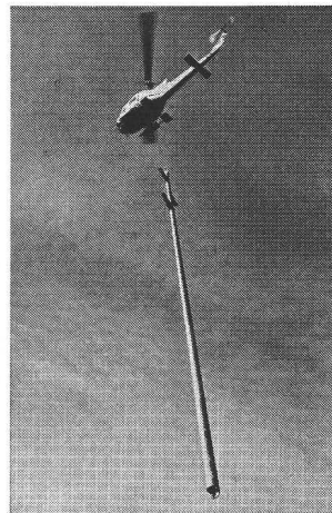
Transport d'un poteau de 26 m
