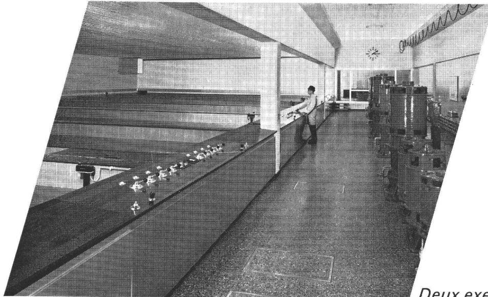
▲ Installation de filtres rapides de Champ-Bougin, appartenant à la ville de Neuchâtel, pour le traitement d'eau du lac en eau potable. Capacité 1800 m<sup>3</sup>/h
