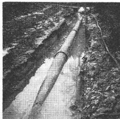
canalisations conduisant les eaux polluées sur ces installations se doivent d'être absolument étanches et résistantes à la corrosion. Les tuyaux de canalisation ETERNIT vous donne la certitude que chaque molécule d'eau usée parvient à destination, fait que les expériences entreprises par l'EMPA
