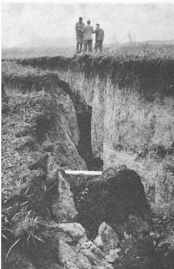
Fig. 8. — Fissure dans la craie lacustre, apparue à peu de distance de l'Areuse.
