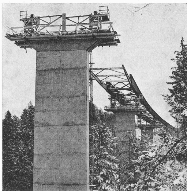
Fig. 4. — Lancement de l'ossature métallique du pont aval.
