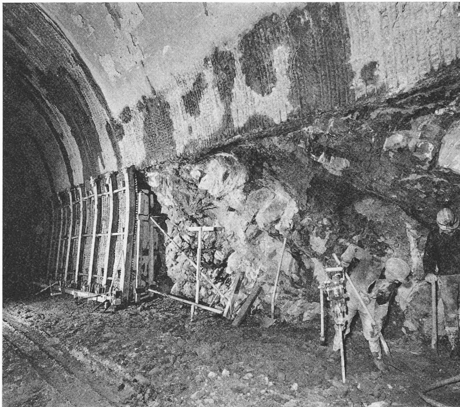
Fig. 3. — Tunnel de Chauderon.
