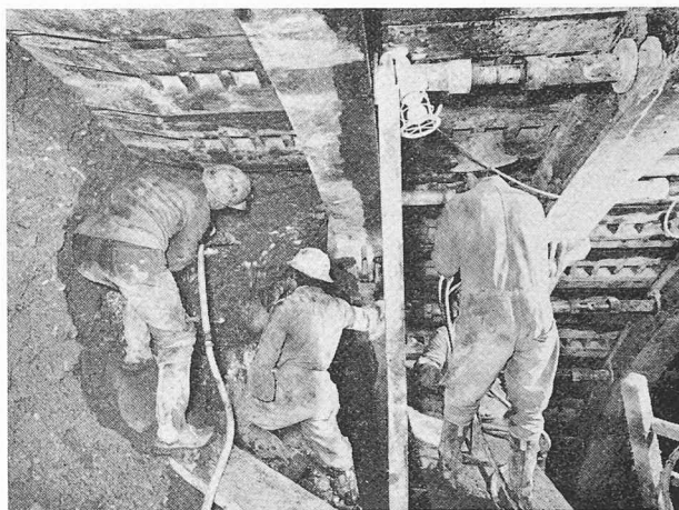
Fig. 9. — Avancement des lances dans la moraine. En haut à droite : vérin.
