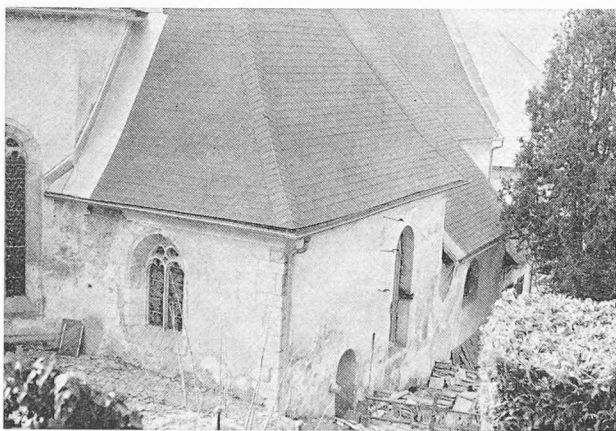
Fig. 12. — Klein Saint-Paul, Carinthie, église paroissiale. Ardoises d'amiante-ciment de 40×40, de couleur gris noir. L'effet est meilleur que celui des losanges, mais ne vaut pas celui des bardeaux.
