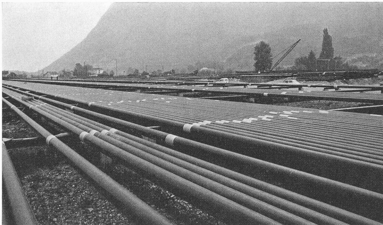
Fig. 4. — Le chantier d'assemblage des tubes au Bouveret.
