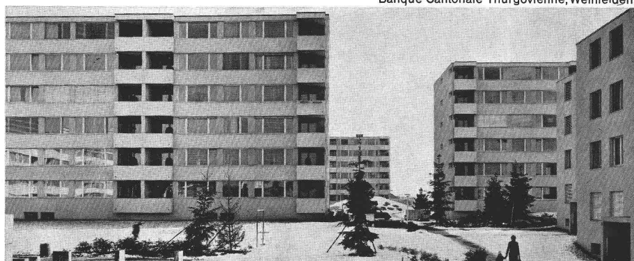
Complexe d'habitation de Rain, Jona SG
