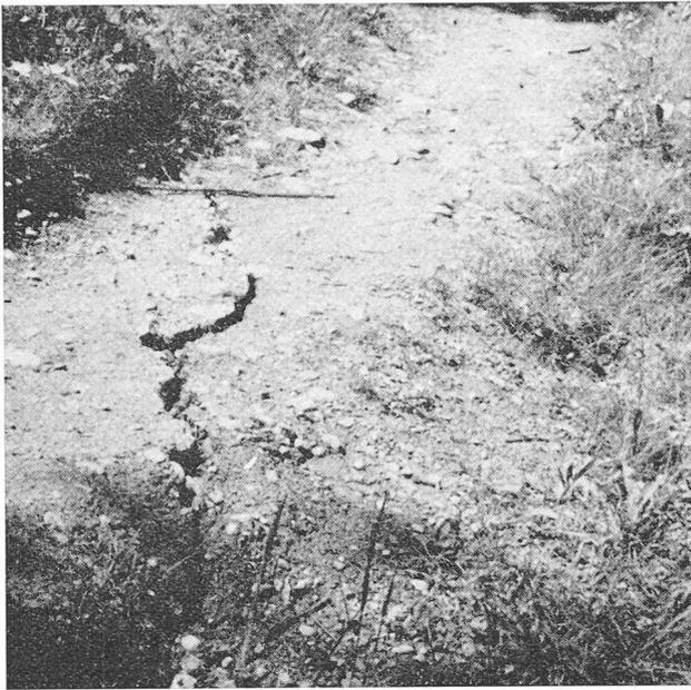
Fig. 16. — Fissure le long d'un chemin de berge ouverte lors de la vidange de 1972.
