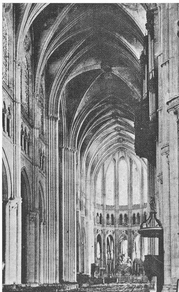
Fig. 18. — Cathédrale de Chartres, 1194-1220. Vue intérieure. Remarquer les piliers cantonnés.
