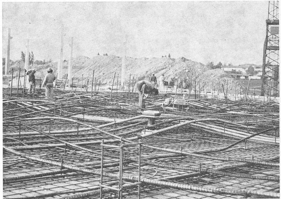
Fig. 7. — Vue détaillée d'un câblage avec supports des câbles, grille d'écoulement et chevalets de réglage du niveau supérieur de la dalle.
